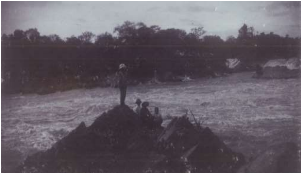
Fig. 25 : Peter Hauff (avant dernier à d.) en compagnie de MM. Guldberg et Fenger en aval des chutes de Phapeng (1903)
